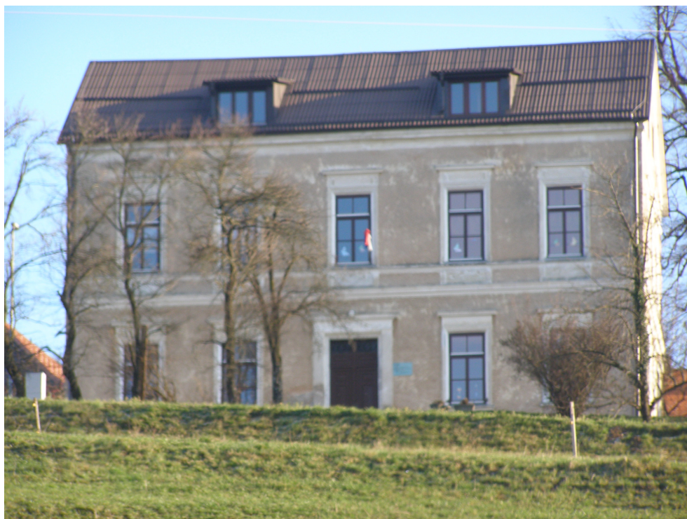
Pogled na glavno fasado (severozahod) šole z neustreznimi strešnimi okni ter neustrezno kritino.
