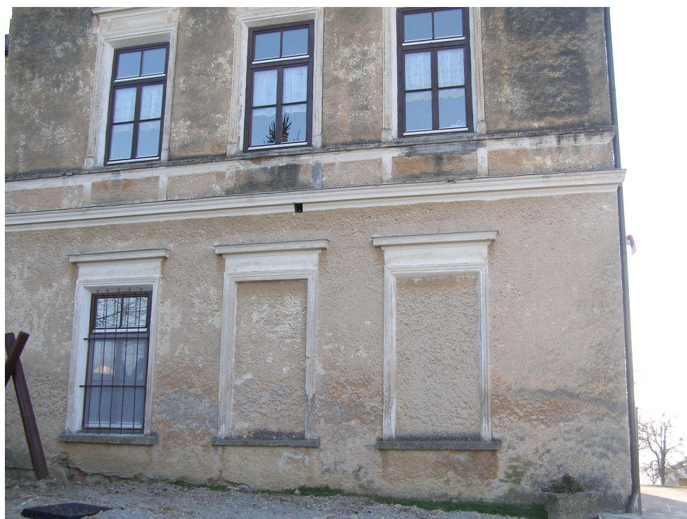
Pogled na del stranske fasade (severovzhod) šole. Vidni dve slepi okni v pritličju ter dve okni v nadstropju z manjkajočimi podokenskimi tablamami z okrasjem.
