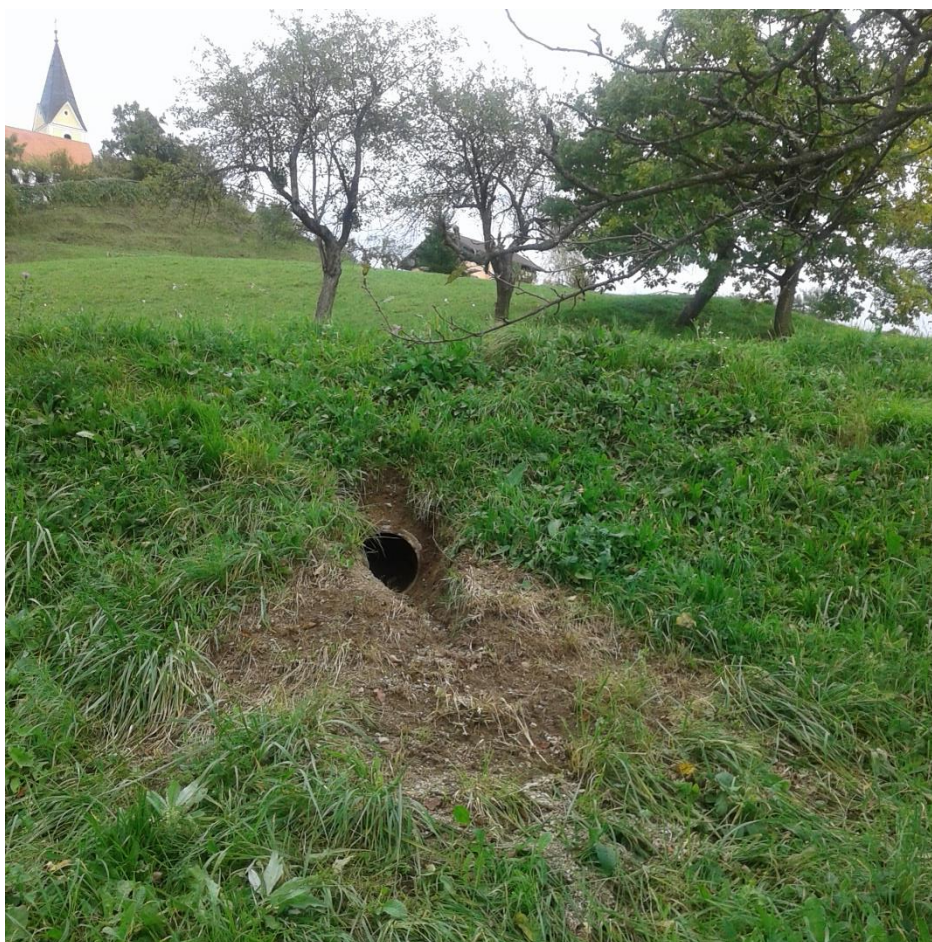
Slika 6: Prikaz obstoječega izpusta iz prepusta pod LC 200191 na travnik
