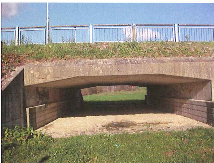
Slika 9: pododsek 7 – inundacijska odprtina pod lokalno cesto za Jagoče
