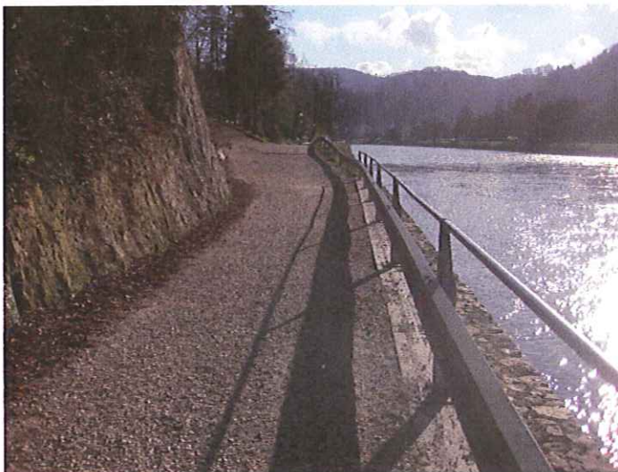
Slika 10: pododsek 8 – obstoječa sprehajalna pot Zdravilišča Laško
