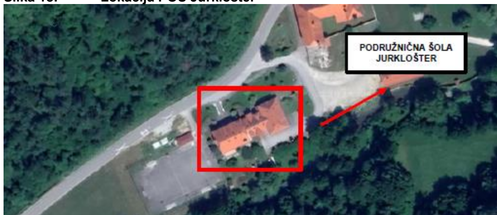
Slika 18: Lokacija POŠ Jurklošter
