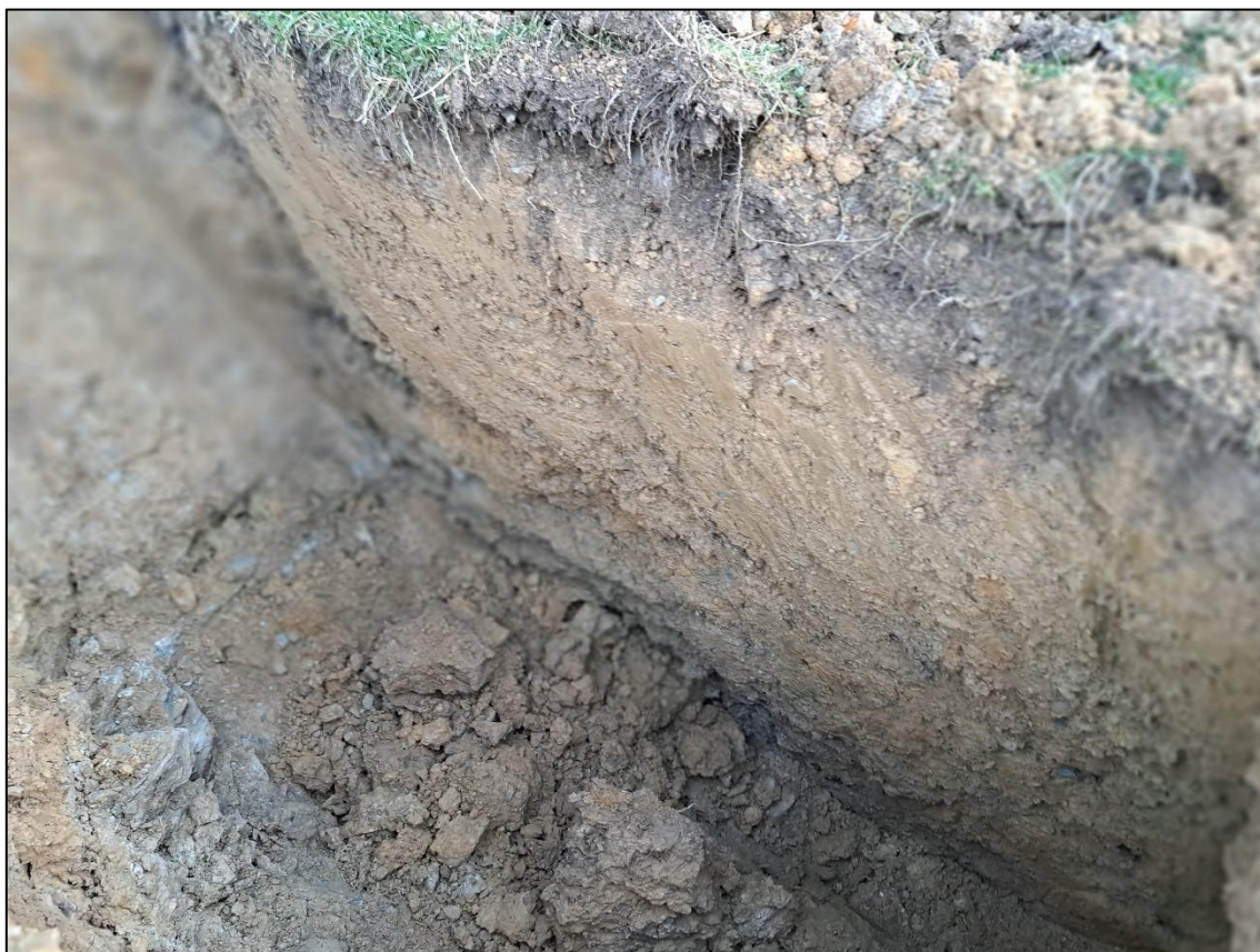
Slika 4: Sondažni izkop na območju predvidenega objekta
